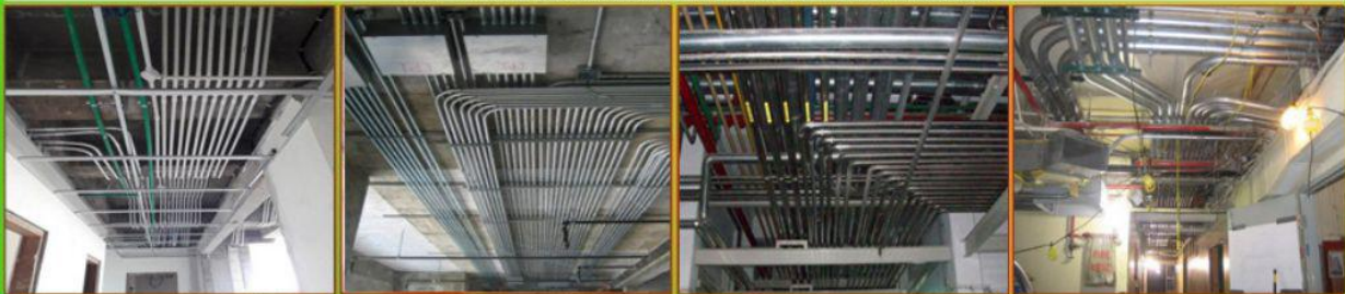
PROSES PEMASANGAN CABLE TRAY DAN LADDER
